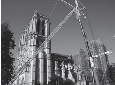
工事中のノートルダム大聖堂 (2023年6月、山本英美利さん撮影)
